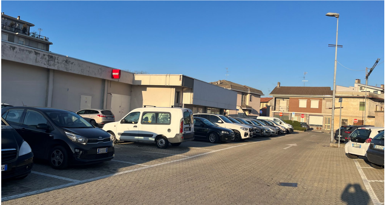
Ripresa fotografica dell'affaccio del lato dell'Ex-magazzini Coop su Via Novara a nord (dal parcheggio interno all'area)
