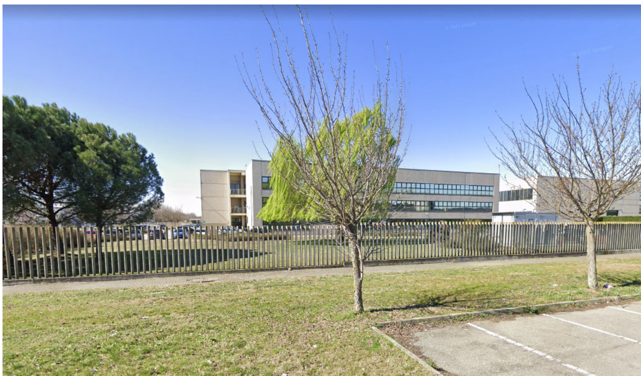
Ripresa fotografica dell'affaccio dell'area produttiva Vertigo Spa su Via Antonio Meucci (vista da est)
