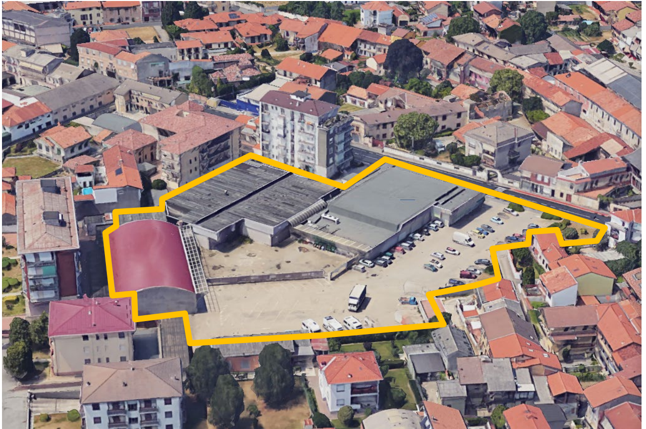
g) Ripresa fotografica dell'Ex-magazzini Coop da est
