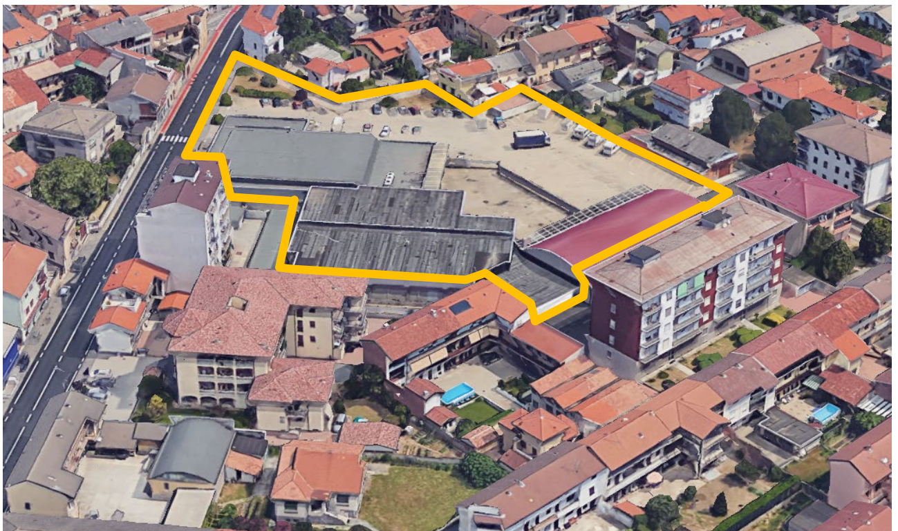
i) Ripresa fotografica dell'Ex-magazzini Coop da sud-ovest
