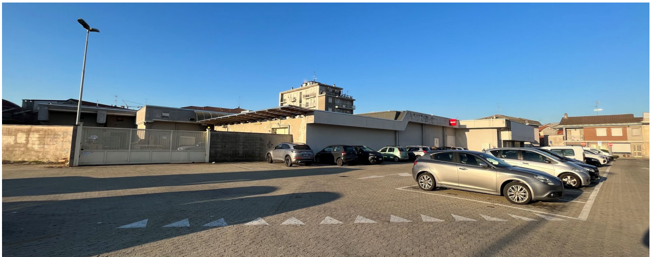
Ripresa fotografica dell'affaccio dell'Ex-magazzini Coop sul parcheggio interno all'area
